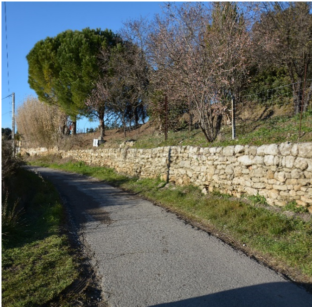
Les murets en pierre le long des voies
