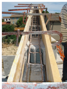
Mise en place d'un chaînage au niveau du rampart d'un bâtiment
