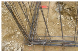
Noeud de chaînage - Continuité mécanique
