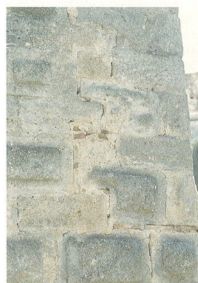
Détail de la " cointure " qui marque la reconstruction de la façade en 1862. Conformément aux devis, le maçon a réutilisé les pierres de la démolition mais, par endroits, il a été obligé de les retailler. Photo. M. Lugand 99.
