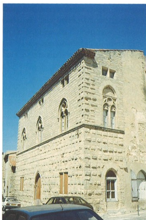
Le presbytère, état actuel. Le bossage du rez-de-chaussée existait à l'origine. Les fenêtres du rez-de-chaussée, du premier et sans doute du second étage ont été créées par l'architecte Bésiné en 1862. A droite, la partie enduite correspond à l'emplacement de l'escalier à vis. L'absence de corbeaux sur la rive du mur pignon conduit à imaginer une tour ou un pigeonnier. Photo. M. Lugand 99.
