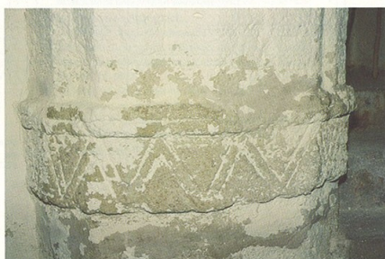
Vestiges de la maison curiale. Bague placée à la base de la croisée d'ogive et faisant office de chapiteau pour les piliers. La décoration de lignes brisées n'existe pas sur les piliers du presbytère. Photo. M. Lugand 99.
