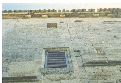
Détail de l'immeuble, côté impasse. Le coup de sabre, au centre, et la différence d'appareil de part et d'autre de ce dernier, suggèrent une construction en deux temps. A droite, la partie la plus ancienne correspond au pièces voûtées de croisées d'ogives, à gauche le Jarrier des frères bénédictins a été reconstruit plus tard, les restes d'une ouverture bouchée, à droite de la fenêtre, en témoignent. Remarque, sur la rive du toit, la ligne de petits corbeaux commune aux deux parties de l'immeuble. Photo. M. Lugand 99.
