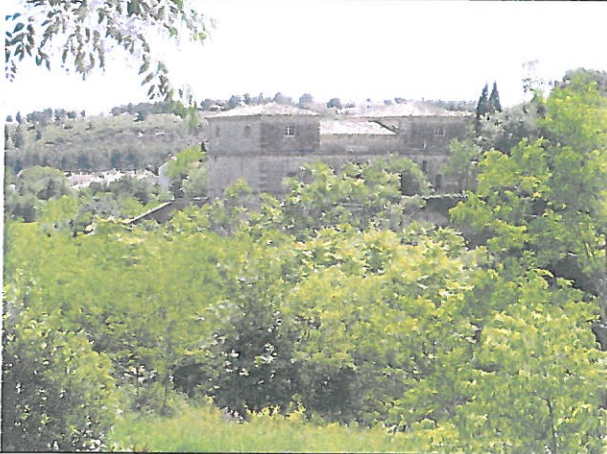
Photo 4 : Le « mur de scène » que constitue le château vu du village dans son vallon. Hélas, depuis sa construction il est lui-même « barré de son panorama initial par l'autoroute.
