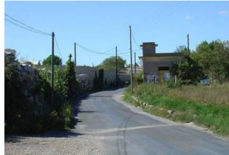
RD 119 Voie d'accès
