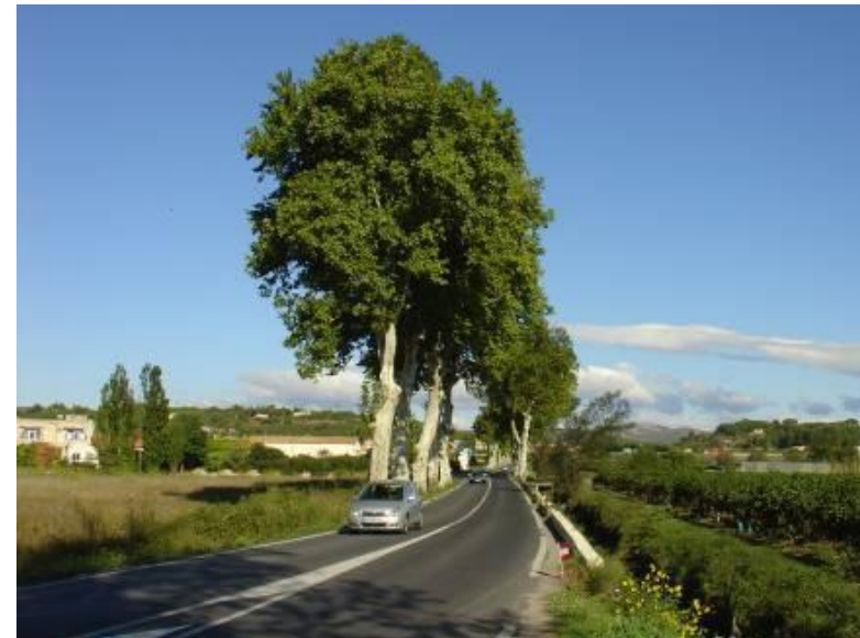
Voie d'accès Sud RD 2
